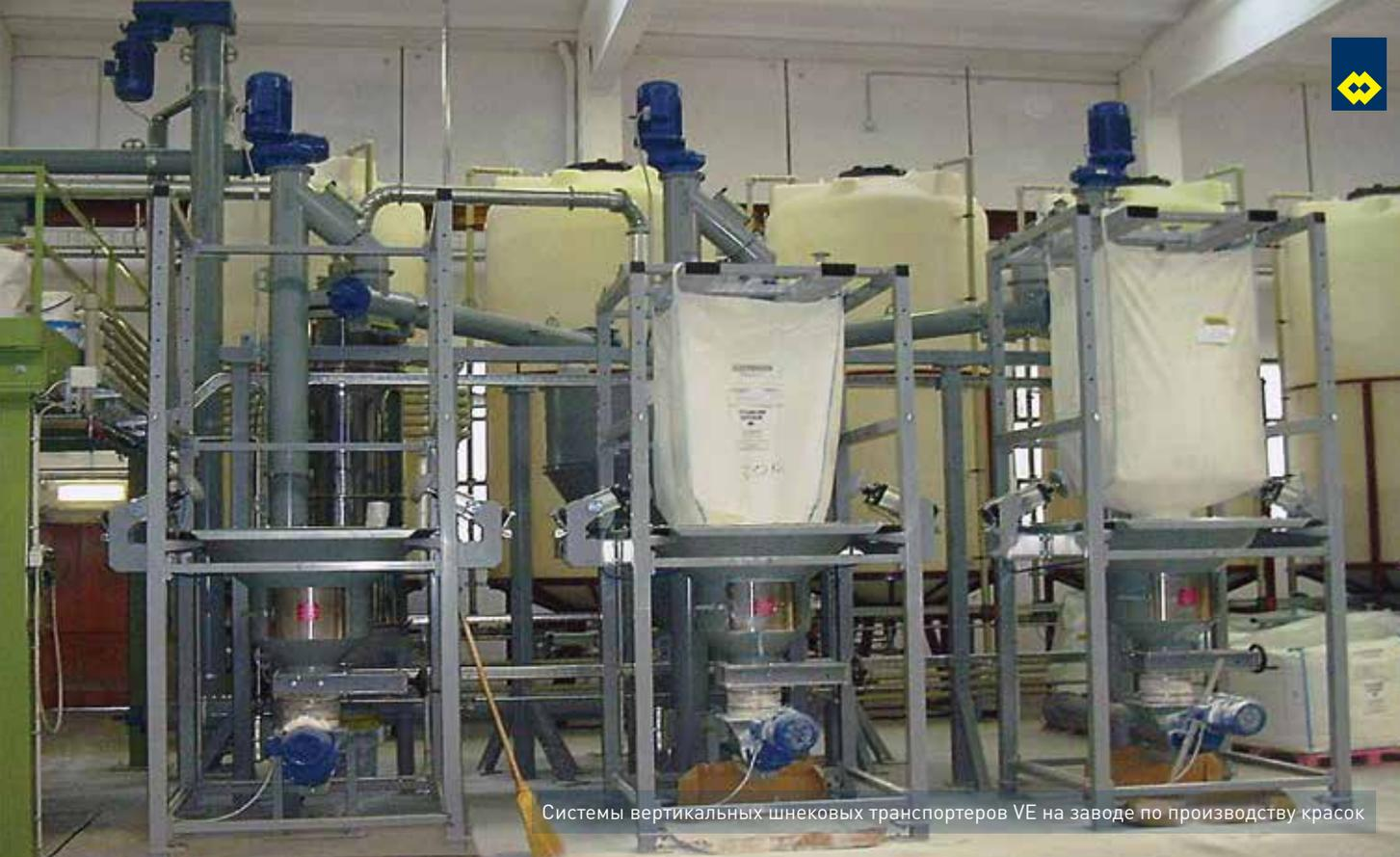
Системы вертикальных шнековых транспортеров VE на заводе по производству красок
